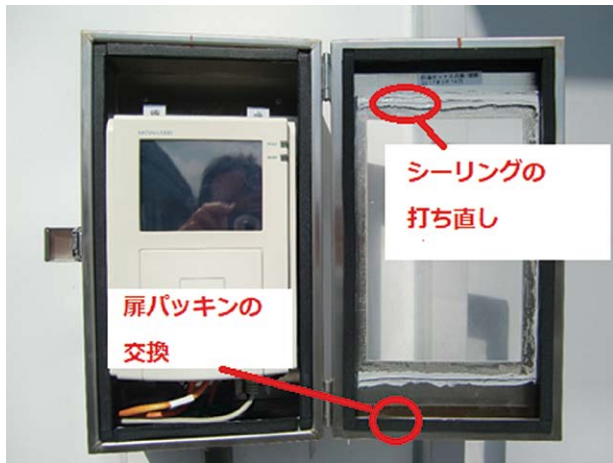
図1 入館管理システムカードリーダー防滴ボックスの補修状況
